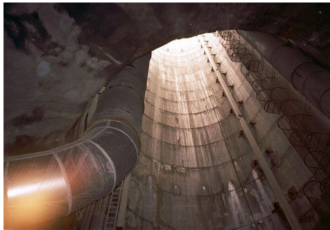
Figura 1.3 – Poço de ventilação
