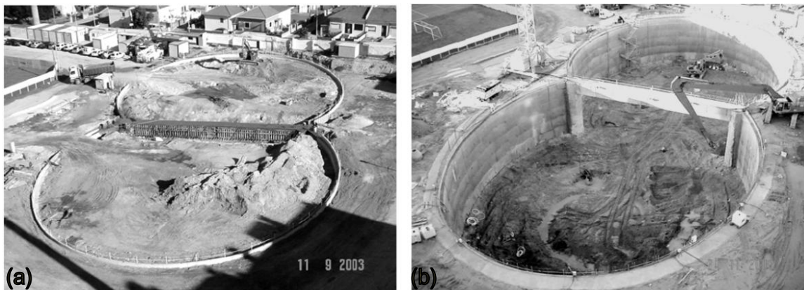
Figura 2.18 – Início (a) e fim das escavações (b)
