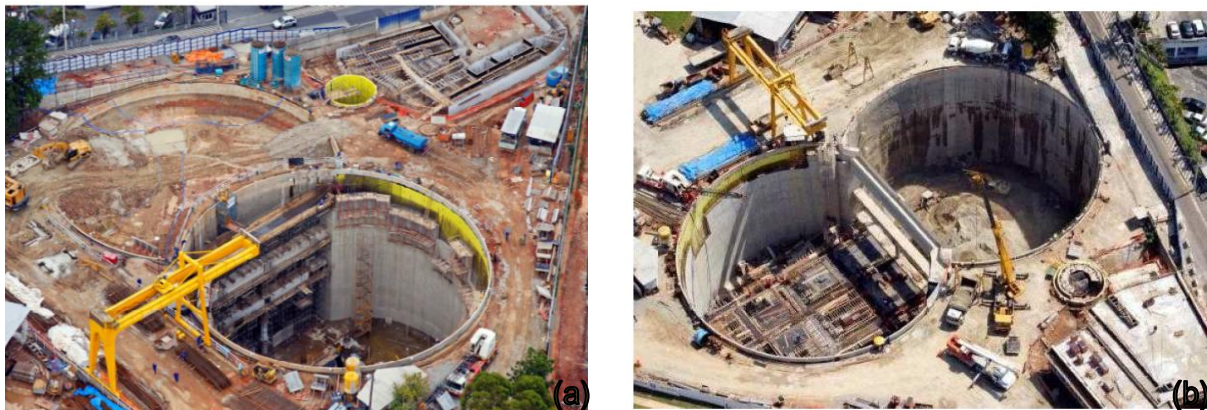
Figura 2.22 – Escavação do poço sul (a) e escavação concluída (b) (Cecílio jr. et al. , 2010)
