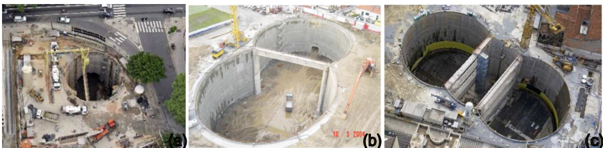
Figura 2.8 – Concepções: circular simples (a), elíptica dupla (b) e circular tripla (c)
