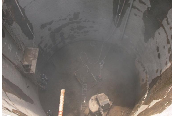
Figura 2.7 – Escavação de um poço em NATM
