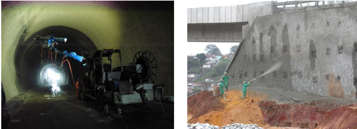
Figura 1.1 – Utilização do concreto projetado
