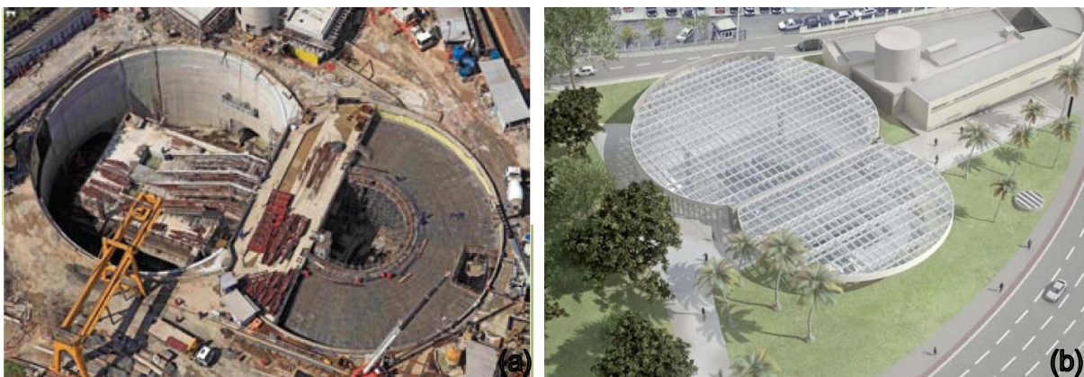
Figura 2.10 – Estação vila prudente – escavação (a) e projeto concluído (b)
