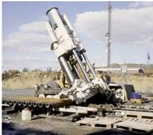
Figura 2.3 – Equipamento para escavação do tipo raise boring
