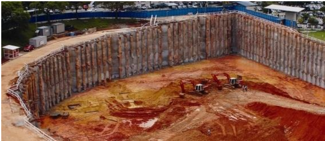
Figura 2.6 – Parede diafragma com estacas
