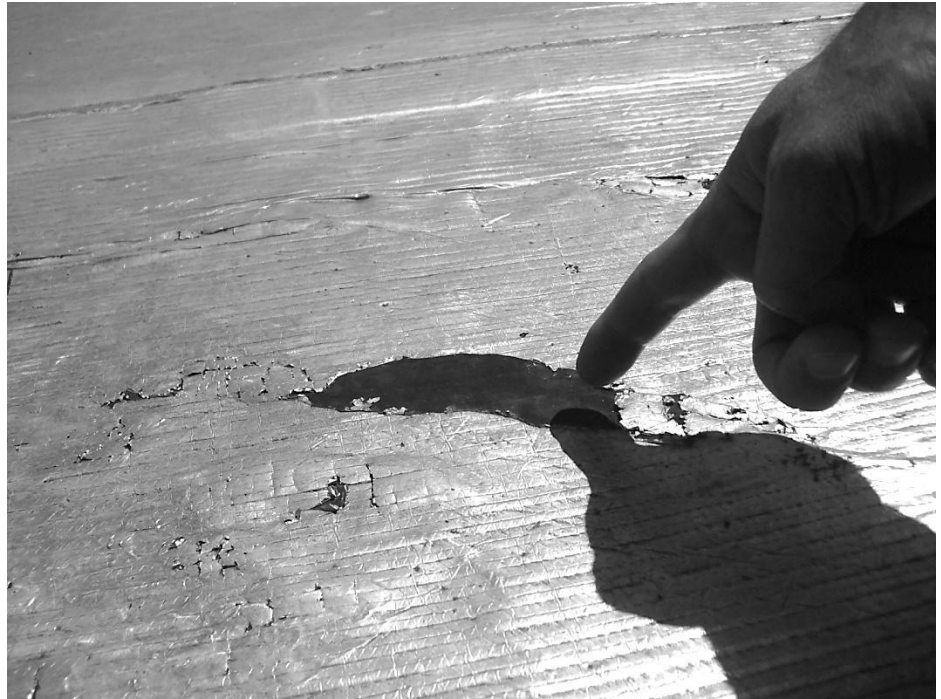
Figura 118 | ICSQ Cobertura. Proteção em manta alumínio Arquivo pessoal. 30.7.2012
