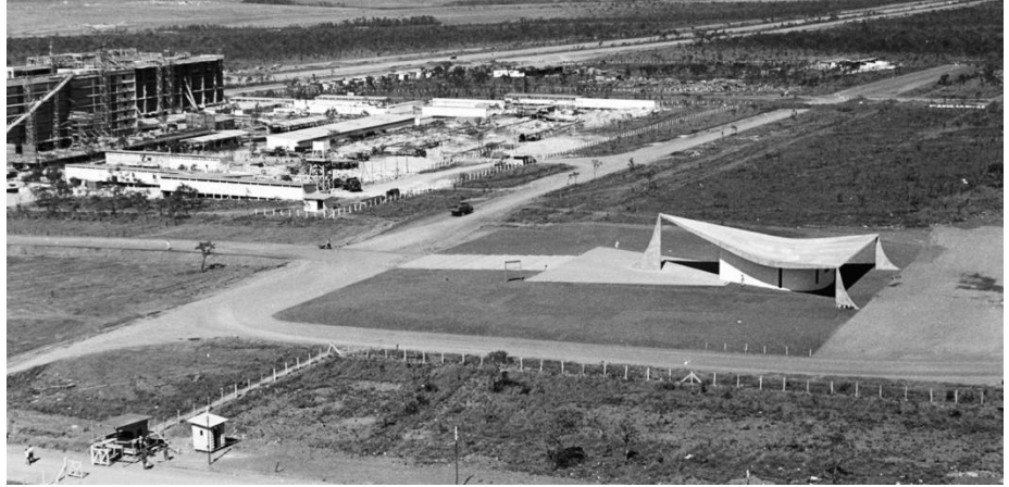
Figura 106 | Implantação da igreja no lote. Mario Fontenelle. 6.8.1958 Levantamento Fotográfico. DAU/NOVACAP. Arquivo Público do Distrito Federal
