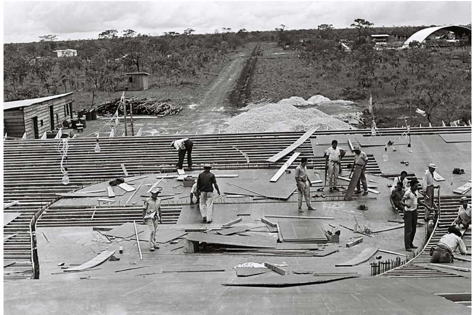
Figura 101 | Execução das fôrmas da cobertura. Mario Fontenelle.18.3.1958 Levantamento Fotográfico. DAU/NOVACAP. Arquivo Público do Distrito Federal
