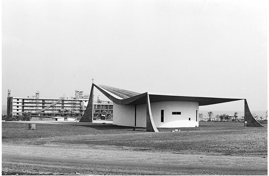
Figura 108 | Lateral com acabamento em pintura e pilares em concreto aparente. 12.9.1958 Levantamento Fotográfico. DAU/NOVACAP. Arquivo Público do Distrito Federal
