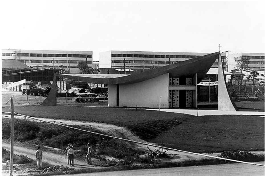
Figura 109 | Movimento de terra realizado. Sem data Levantamento Fotográfico. DAU/NOVACAP. Arquivo Público do Distrito Federal
