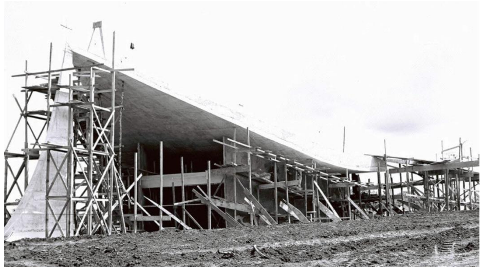
Figura 104 | Escoramento da cobertura. Mario Fontenelle. 22.4 1958 Levantamento Fotográfico. DAU/NOVACAP. Arquivo Público do Distrito Federal
