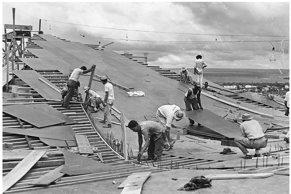
Figura 102 | Execução das fôrmas da cobertura. Mario Fontenelle.18.3.1958 Levantamento Fotográfico. DAU/NOVACAP. Arquivo Público do Distrito Federal
