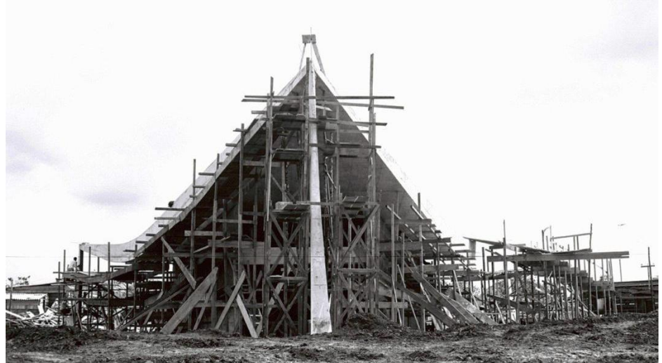
Figura 103 | Escoramento da cobertura. Mario Fontenelle. 22.4 1958 Levantamento Fotográfico. DAU/NOVACAP. Arquivo Público do Distrito Federal
