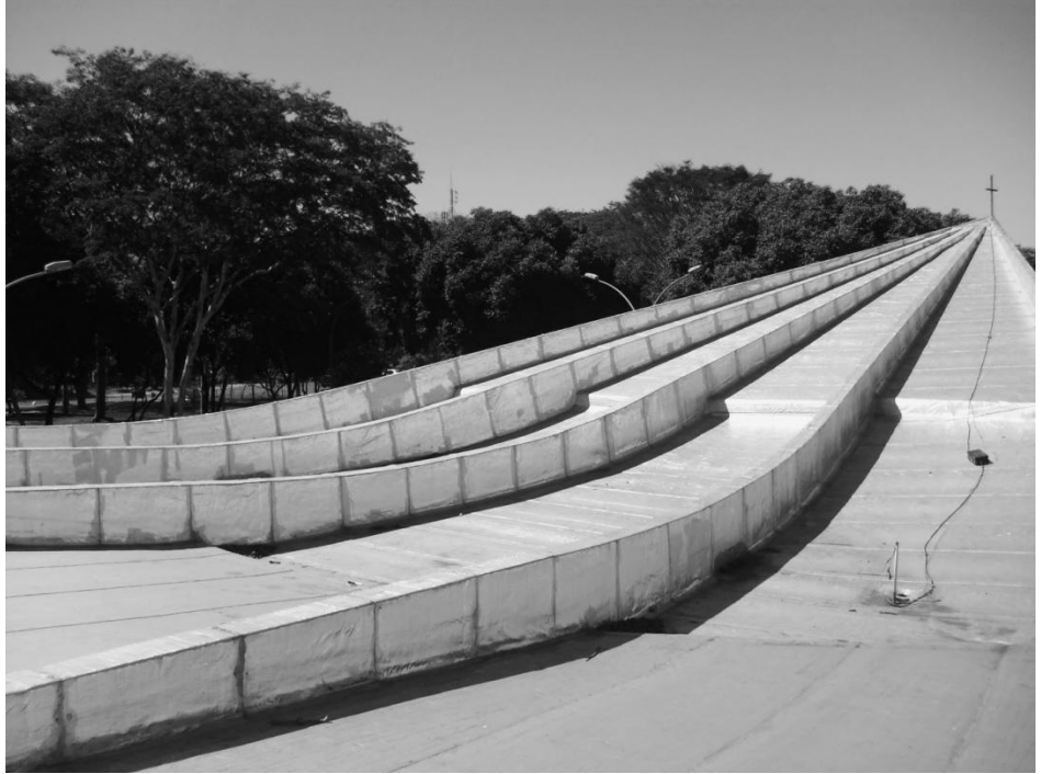
Figura 114 | ICSQ Cobertura. Trecho frontal Arquivo pessoal. 30.7.2012
