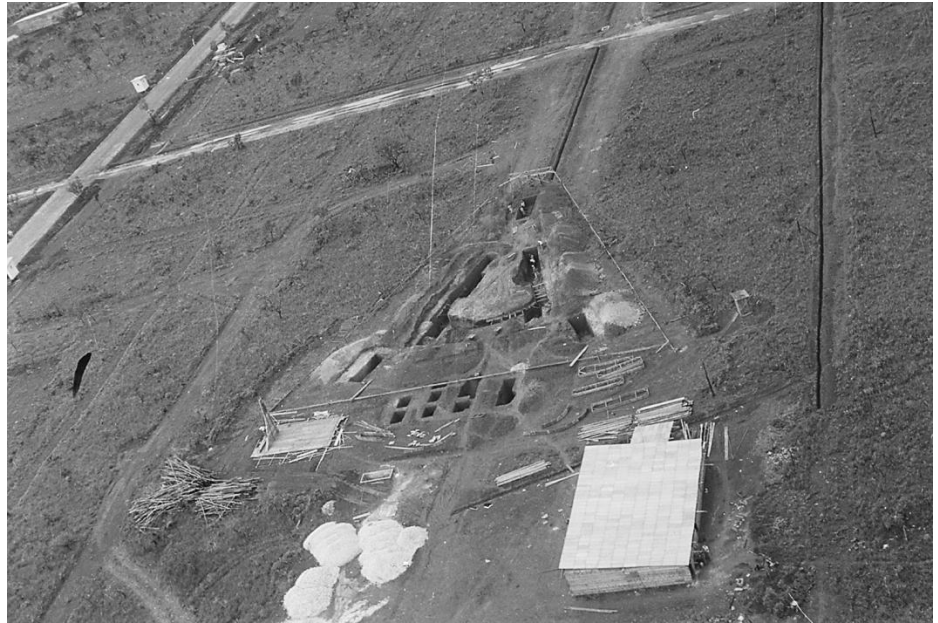
Figura 99 | Execução das fôrmas das cintas, blocos e pilares. 2.2.1958 Levantamento Fotográfico. Arquivo Público do Distrito Federal.
