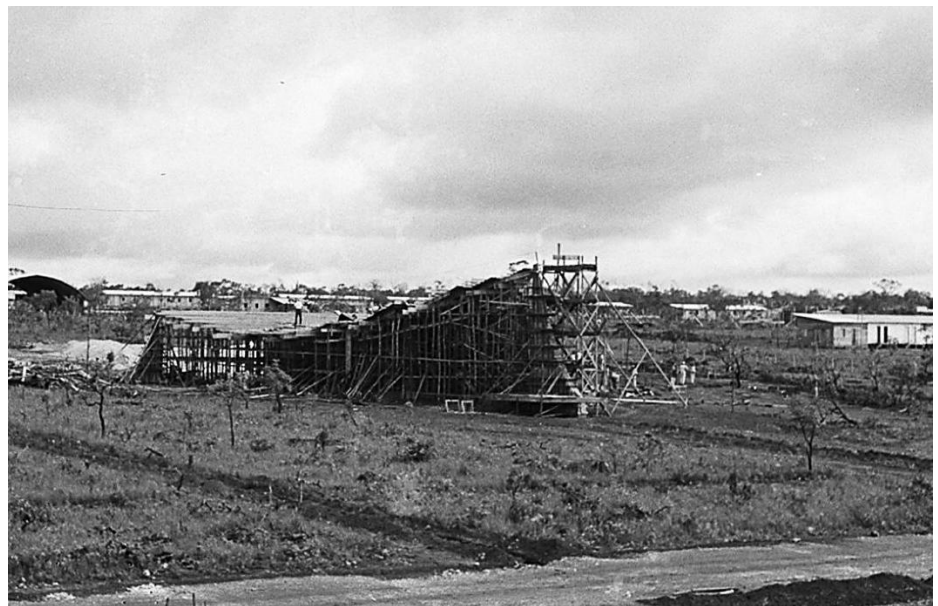
Figura 100 | Igreja e canteiro de obras. 18.3.1958 Levantamento Fotográfico. Arquivo Público do Distrito Federal
