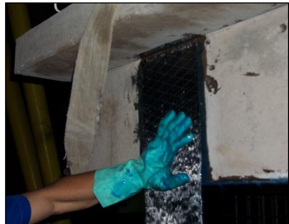
(f) Colocação da ancoragem
