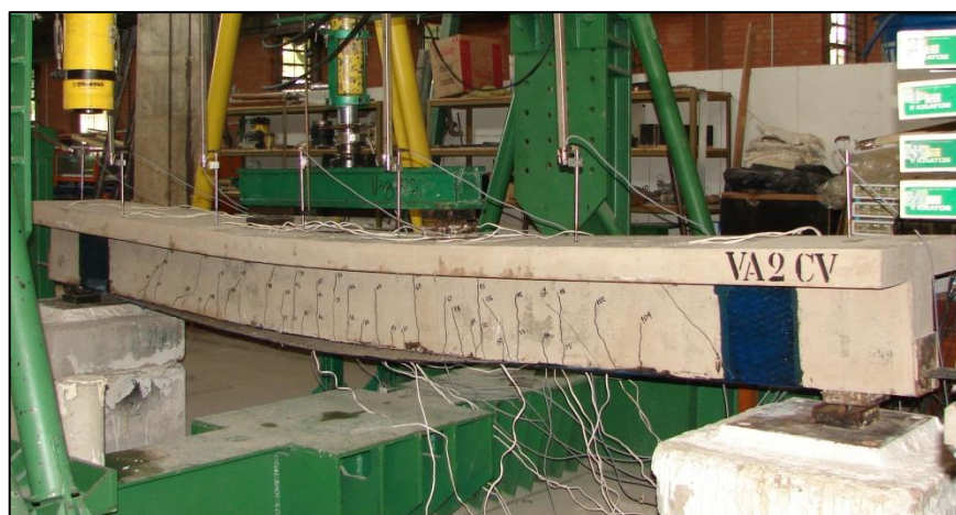
Figura 4.18 – Viga reforçada VA2 - CV após o ensaio
