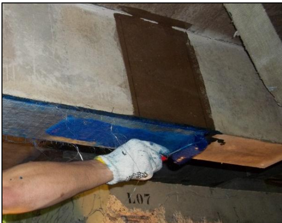
(e) Aplicação do saturante sob a fibra
