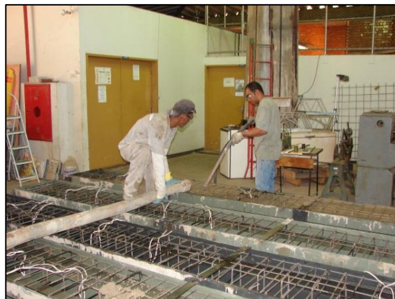
Figura 3.17 – Concretagem
