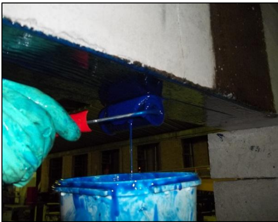
(c) Aplicação do saturante
