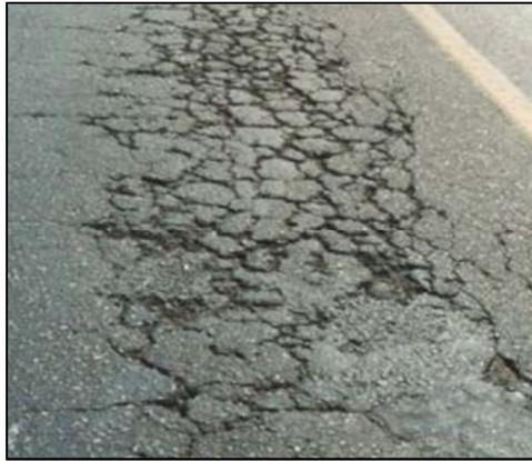
Figura 3.2 – Trincas tipo couro de jacaré advindas dos esforços de flexão
