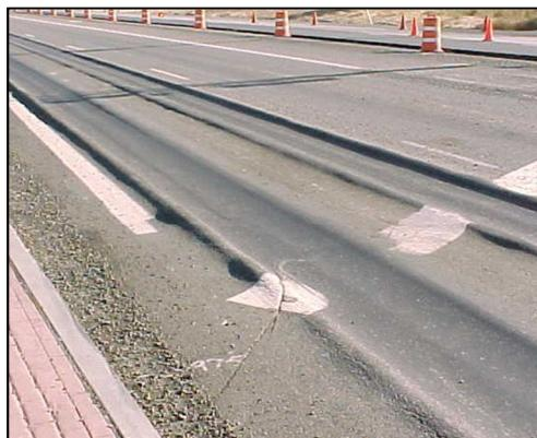
Figura 3.3 – Trilha de roda devido às deformações verticais permanentes do pavimento.
